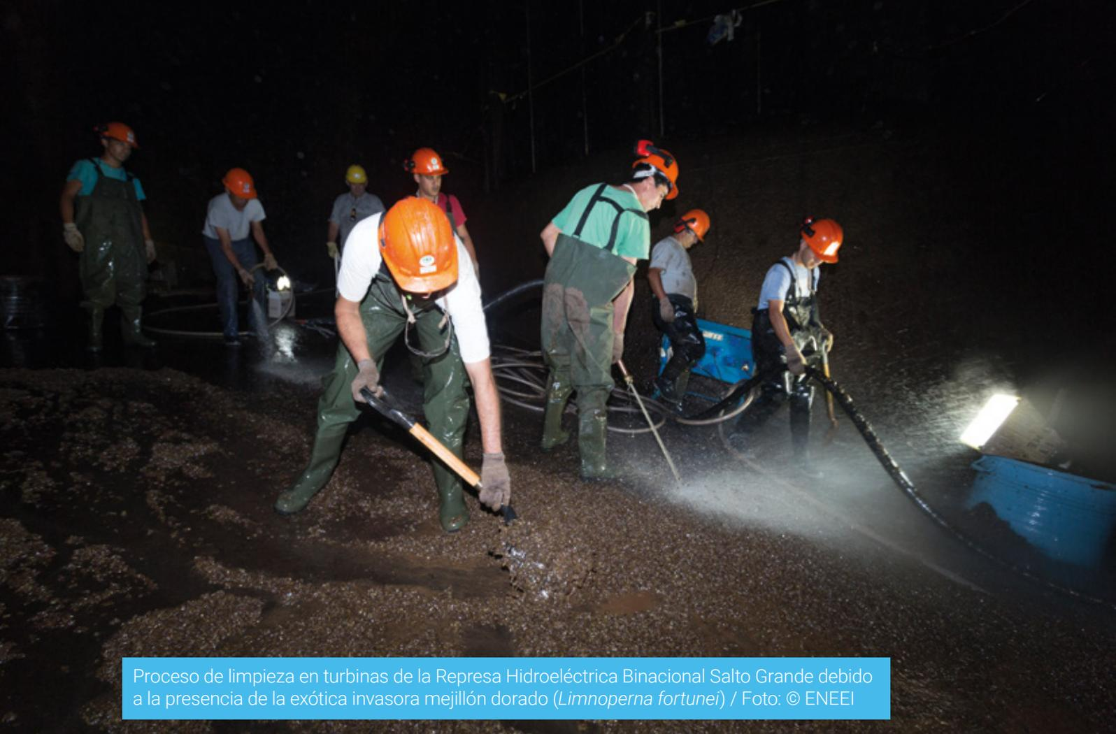
Proceso de limpieza en turbinas de la Represa Hidroeléctrica Binacional Salto Grande debido a la presencia de la exótica invasora mejillón dorado (*Limnoperna fortunei*) / Foto: © ENEEI
